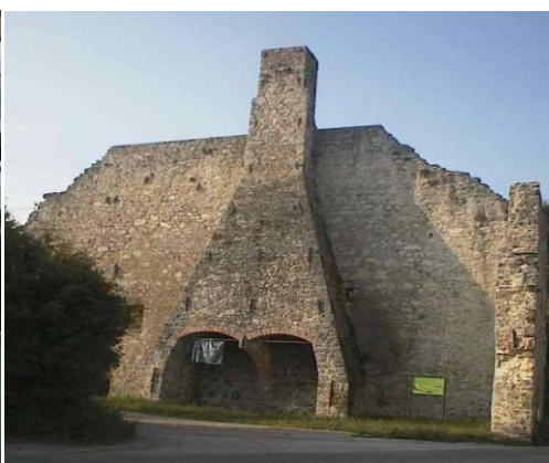
plavž na Dvoru
