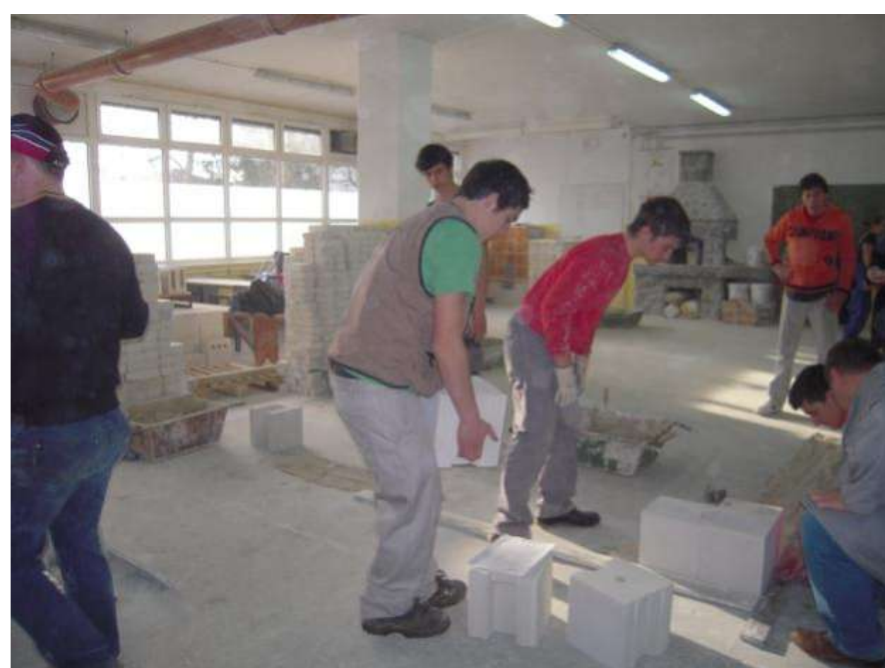
začetek zidanja v vogalu
