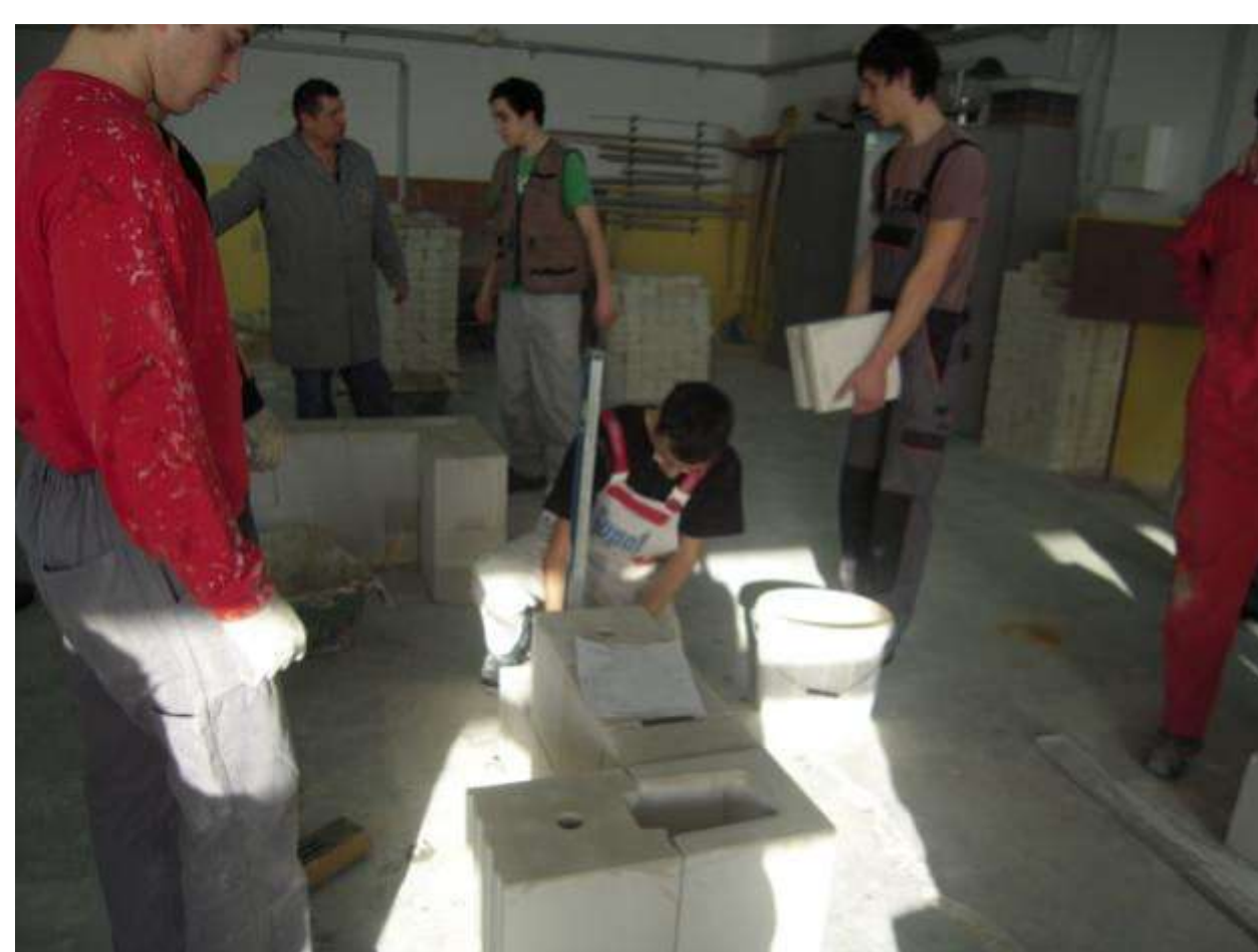
kontrola vertikalnosti
