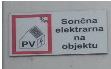
Slika 4: Opozorilni znak za nameščeno sončno elektrarno na objektu
